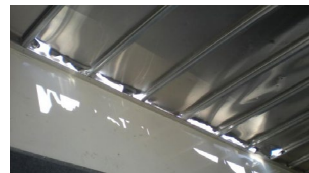
Кровен простор: Оштетена рамка, која што не е во рамки на економична поправка
