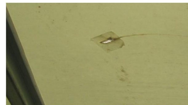
Кровен простор: Перфорирани или оштетени во рамки на економична поправка
